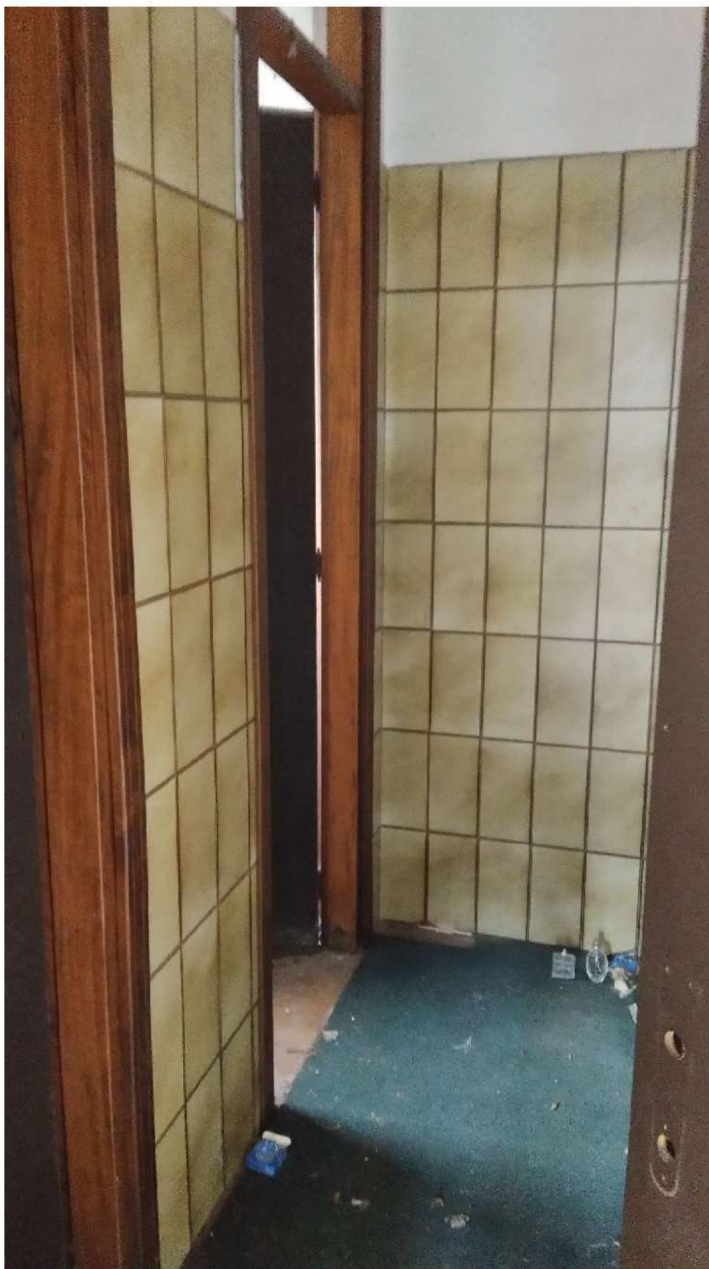
INTERNO DEL LOCALE "H" (anti bagni)
