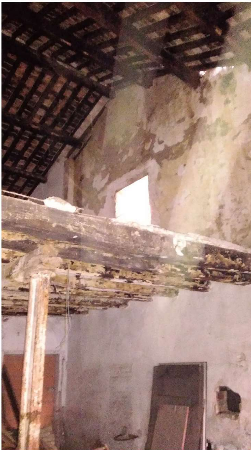
INTERNO DEL LOCALE "C", CON VISTA DELLA TESTA DEL SOLAIO INTERMEDIO, DELLA COLONNA METALLICA DI SOSTEGNO DELLA TRAVE DI ROMPITRATTA E DELLA COPERTURA ORIGINARIA AVENTE ORDITURA DELLE TRAVI "ALLA VICENTINA" CON MORALI E TAVELLE PIENE IN LATERIZIO (con piccola porzione della falda nord in stato precario, a ridosso della muratura, si vede la luce esterna)
