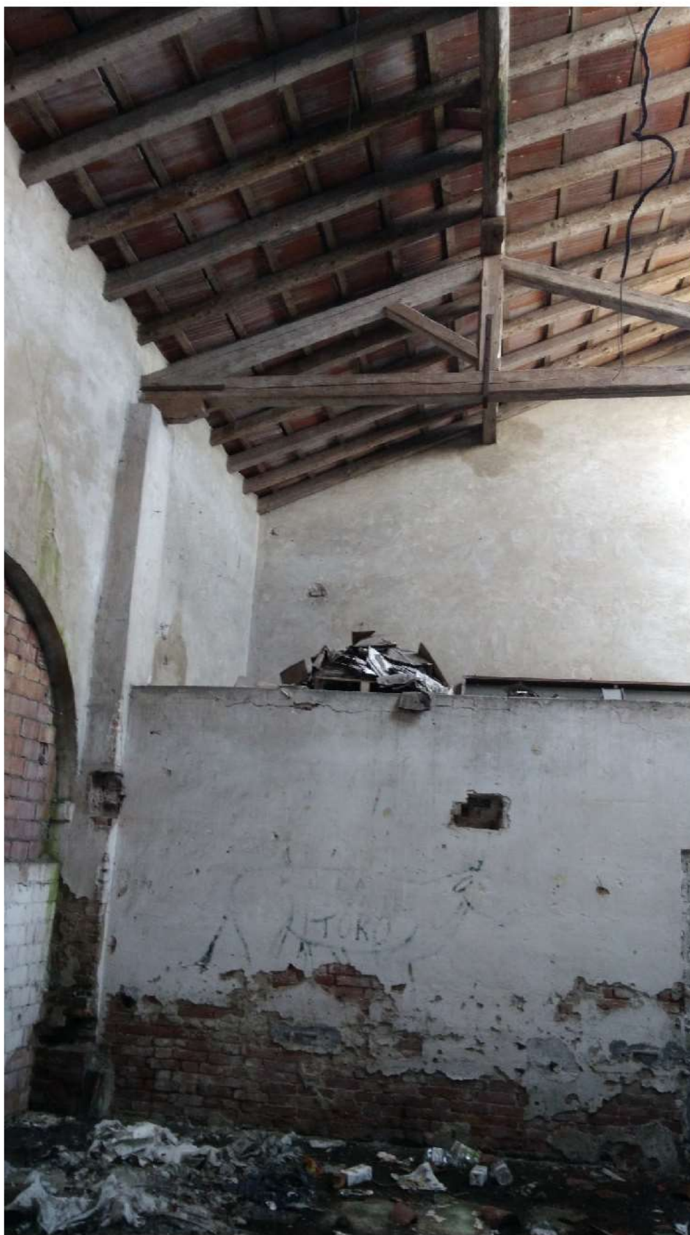
PARETE NORD DEL LOCALE "F", CON IL MURO CHE DELIMITA L'ADIACENTE LOCALE "E" E LA SOPRASTANTE PORZIONE INTEGRA DELLA COPERTURA. VISIBILE L'ARCO TAMPONATO SUL LATO SUD
