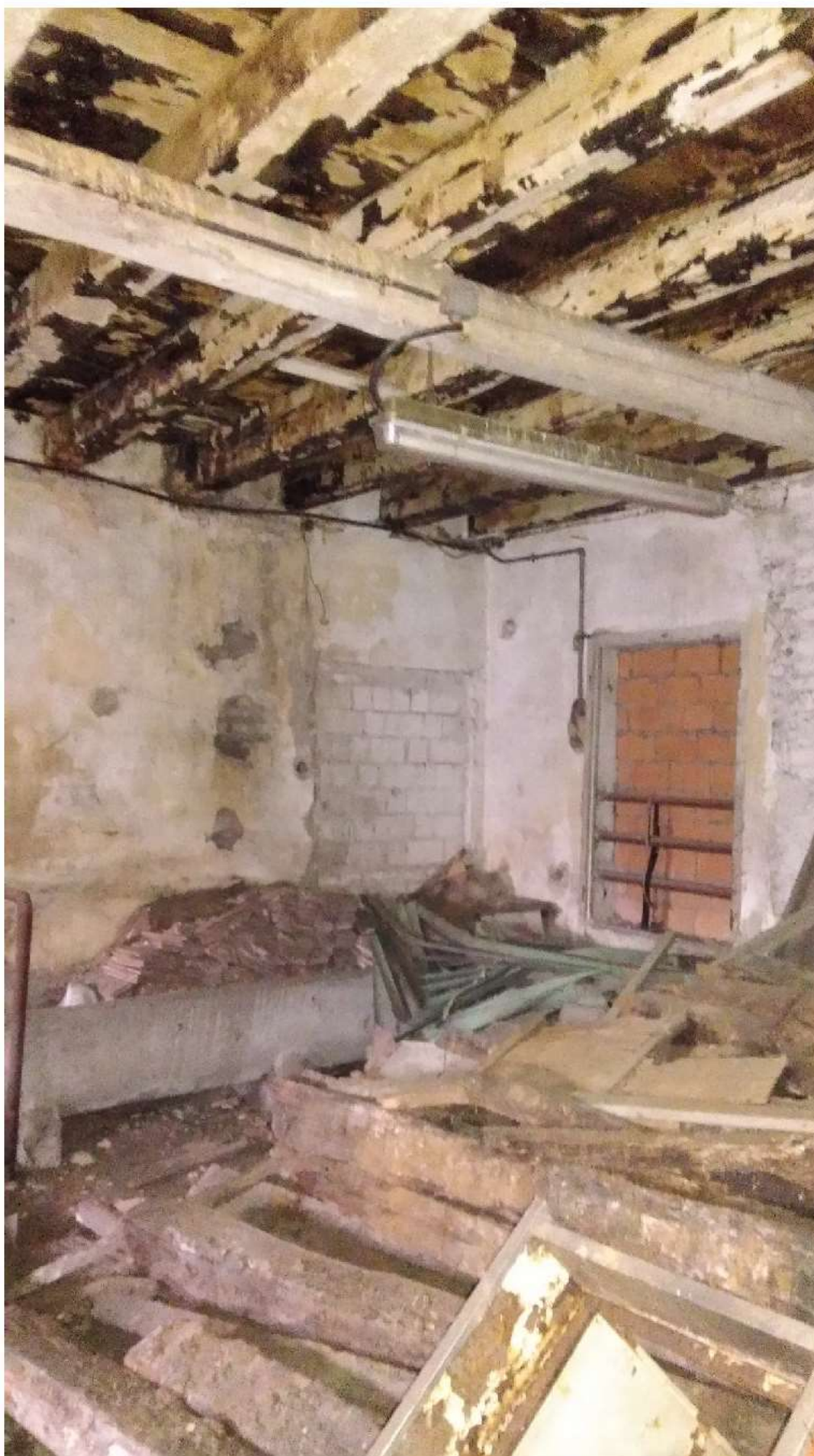
INTERNO DEL LOCALE "C", ANGOLO SUD EST, ZONA CON IL SOLAIO INTERMEDIO (molto ammalorato) E RELATIVA TRAVE DI ROMPITRATTA
