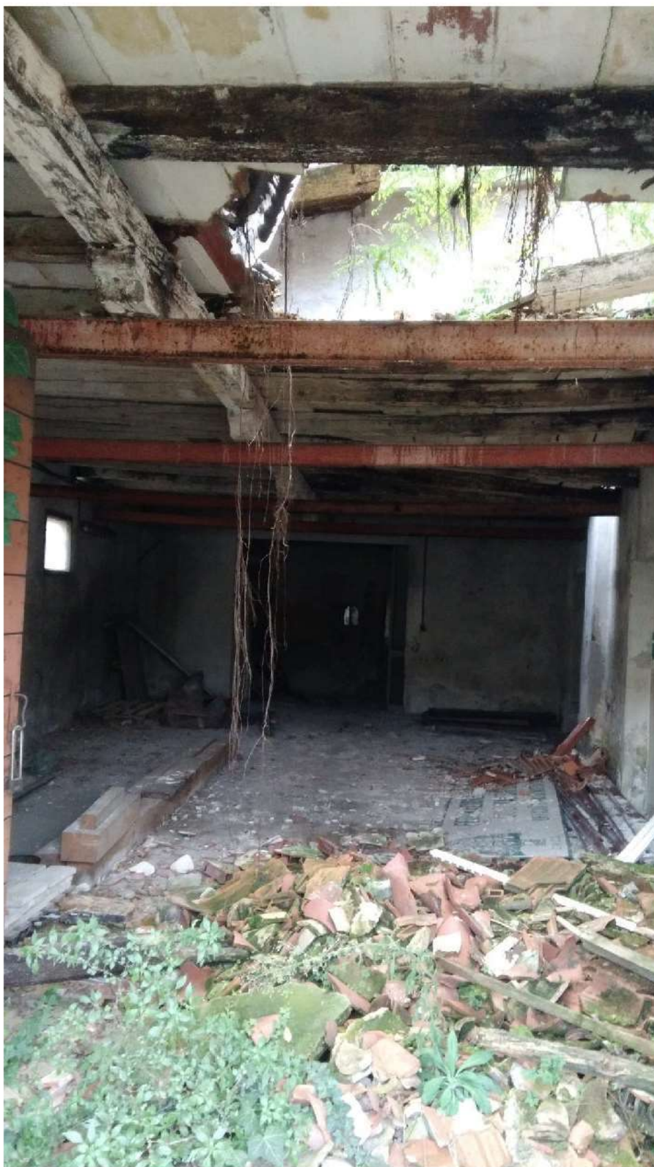
LOCALE "A" – PIANO TERRA, CON DETTAGLIO DELLA PORZIONE CROLLATA DEL SOLAIO INTERMEDIO IN PROSSIMITA' DELL'INGRESSO SUL LATO OVEST E LE RELATIVE MACERIE. LE PUTRELLE IN ACCIAIO
