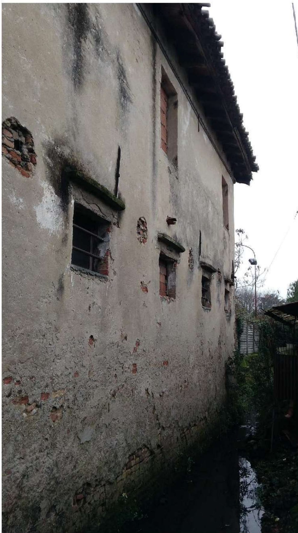
DETTAGLIO DELLA MURATURA LATO NORD DELLA PORZIONE "ALTA", CON LA PARTE PERICOLANTE DELLA CORNICE DI GRONDA. LE PUNTELLAZIONI PREVISTE ARRIVANO FINO ALLA FINESTRA IN CENTRO IN ALTO
