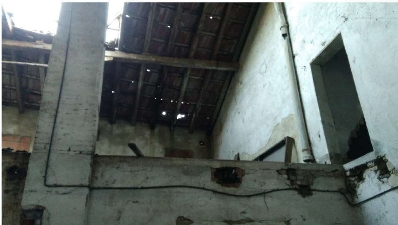
VISTA DALL'INTERNO DEL LOCALE "F" DI PARTE DELLA COPERTURA CROLLATA SUL SOLAIO INTERMEDIO DEL SOTTOSTANTE LOCALE "A" (zona est della falda nord)
