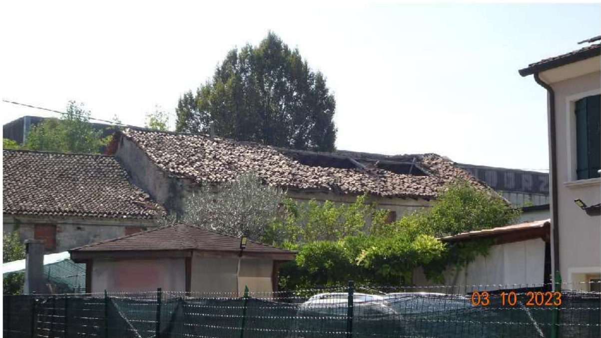
Implosione della copertura
